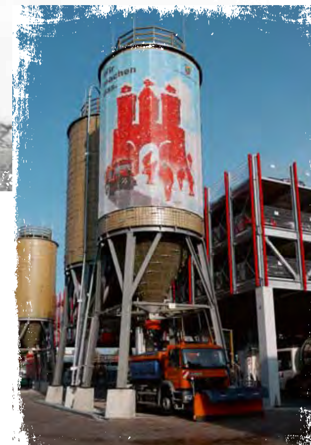
In diesen Silos und in mehreren Hallen lagern bis zu 27.000 Tonnen Salz – das reicht auch für harte Winter.
